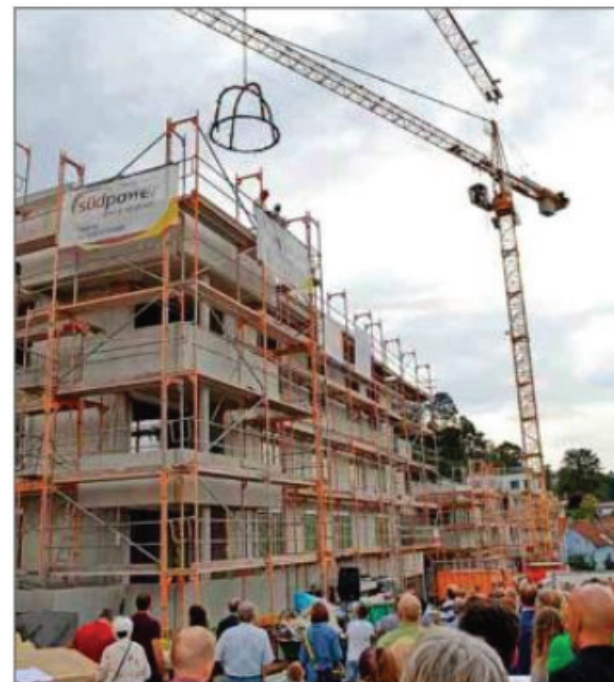
Der Richtspruch wurde vom Dach eines der vier Mehrfamilienhäuser gesprochen.
